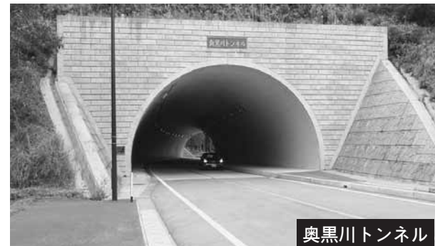
奥黒川トンネル
